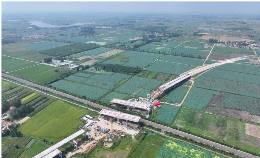
8月20日,通过逆时针81.2°的转体,中铁七局207国道襄阳市襄州至宜城改建工程单体重约7350t的双幅转体T构桥跨越汉丹铁路,与铁路南北两侧桥梁实现精准对接,顺利完成转体。(四公司 叶畅 刘晶晶 摄影报道)
